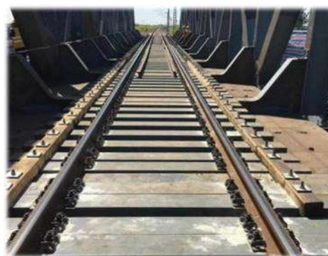
Рисунок 1.13 – Китай, композиционный мостовой брус; отходы ПВХ, порошок отходов резины, отходы ПТФЭ, отходы ФЭП, отходы ПП и т. д. [36]
